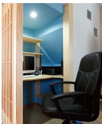
階段下のデッドスペースを活用 階段下に机を造作しデッドスペースを有効活用。施主の思いやライフスタイルに合わせ、さらに楽しめる家づくりを提案。
