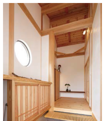
木の魅力が満載、純和風の玄関 パイン、タモ、スギ。玄関だけで数種類の木を使用。3メートルの柱1本で、1.2リットルの水分を吸収するほど調湿性に優れています。
